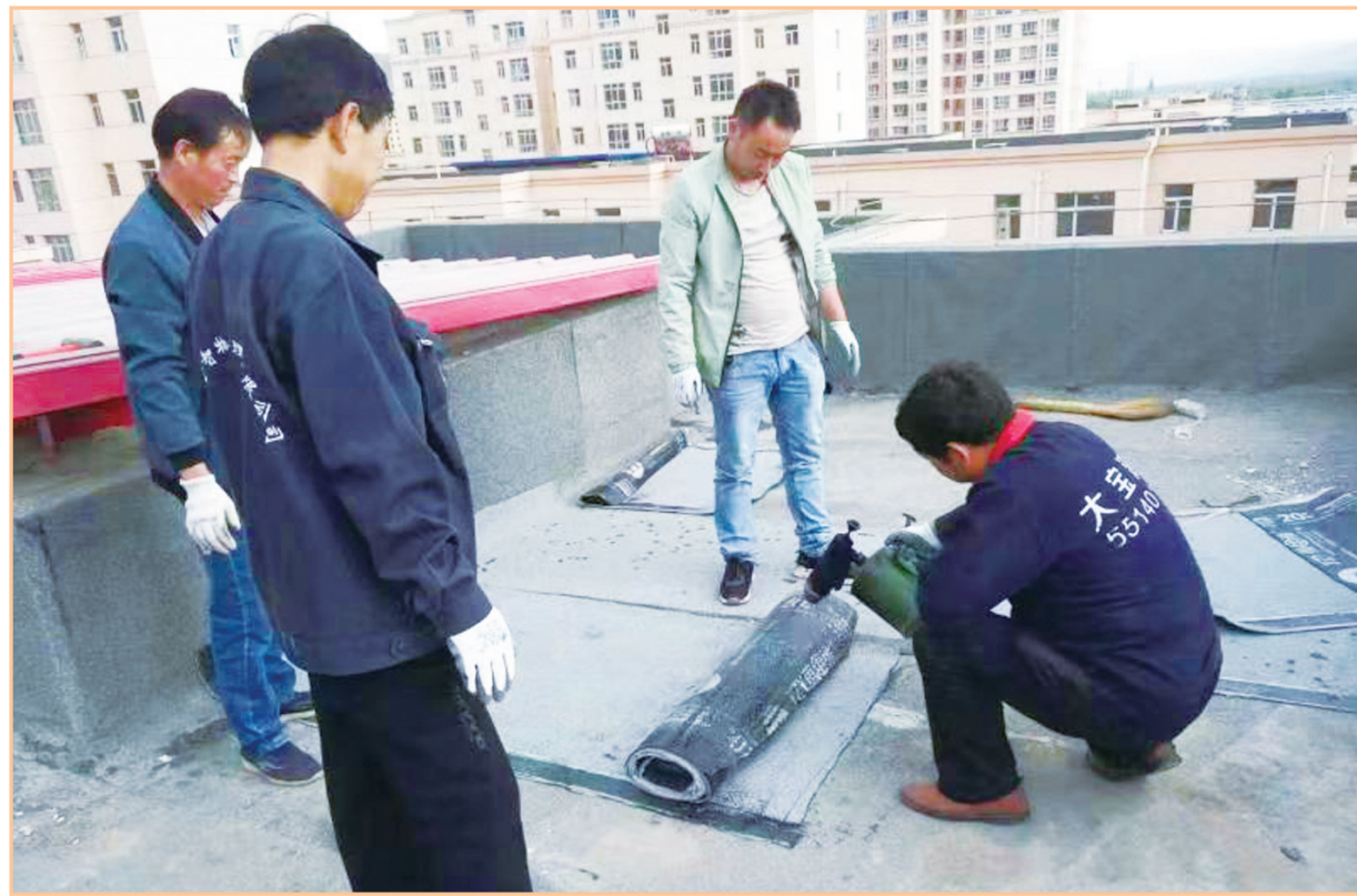
图为住房保障服务中心安排专业工程人员对漏水屋顶进行维修。
