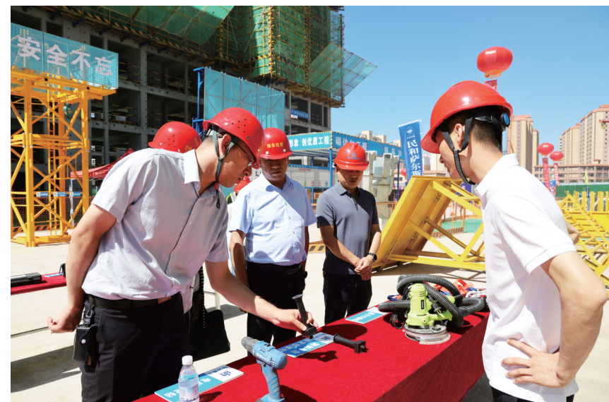
7月21日,海东市房屋市政工程质量安全标准化现场观摩会在民和回族土族自治县召开,旨在扎实推进全市建筑领域安全生产重大事故隐患专项排查整治及房屋市政工程安全生产治理行动工作部署高标准落实,深化安全生产、工程质量管理,遏制各类事故发生。图为观摩建筑工地现场。本报记者 李永兰 摄
