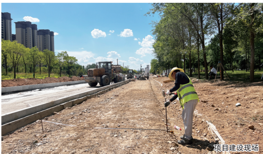
项目建设现场
