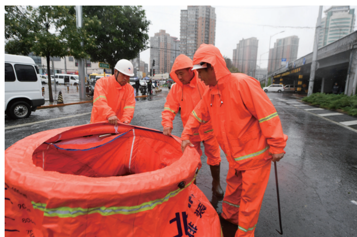
在北京市朝阳区十里河桥附近，北京排水集团的工作人员在检查防汛筒。
