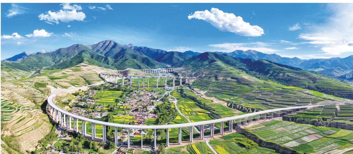
日前,随着最后一方混凝土的顺利浇筑,青海首座高速公路螺旋曲线桥—G213克克至唐格公路乐都至化隆段斜沟5号特大桥双幅连续刚构施工顺利合龙,为该桥项目2024年实现通车目标奠定了坚实基础。据悉,斜沟5号特大桥是乐化高速项目重点控制性工程,桥长1378米,为典型的“大纵坡、高横坡、小半径”桥梁。图为青海省首座高速公路螺旋曲线桥全景。
