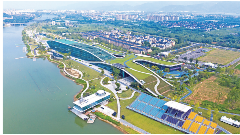
8月24日,空中俯瞰杭州富阳水上运动中心,屋顶被绿植覆盖(无人机照片)。杭州富阳水上运动中心为杭州亚运会赛艇、皮划艇(含静水、激流回旋)项目的比赛及训练场地。该运动中心毗邻富春江,与亚运村相距约36公里,含赛事管理、观众服务和媒体运行等功能。
