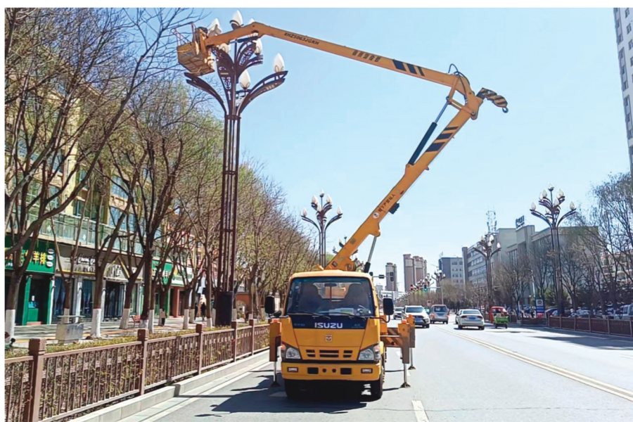
路灯是城市重要的基础设施之一,连日来,海东市平安区城市管理综合行政执法局按照“分区域、分路段”的原则,将城区照明设施配备了专门的管护维修人员,采取“日间与夜间”巡查相结合的方式,对城区管辖范围内的路灯、夜景亮化等设施设备进行全面细致地检查并做好巡查记录,保障城区路灯设施的完好率和亮灯率。图为平安区城管局维修人员正在对一处出现故障的路灯进行修复。
