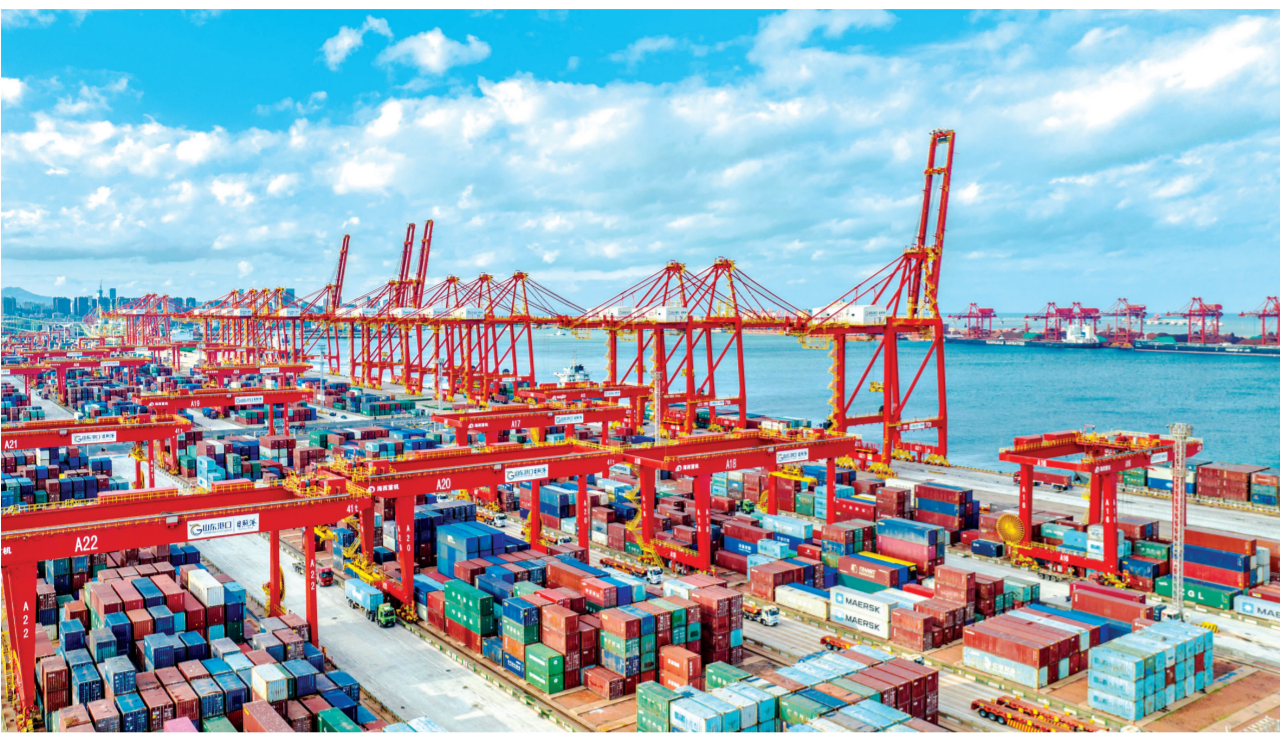
2024年7月2日拍摄的山东港口日照港集装箱码头(无人机照片)。
