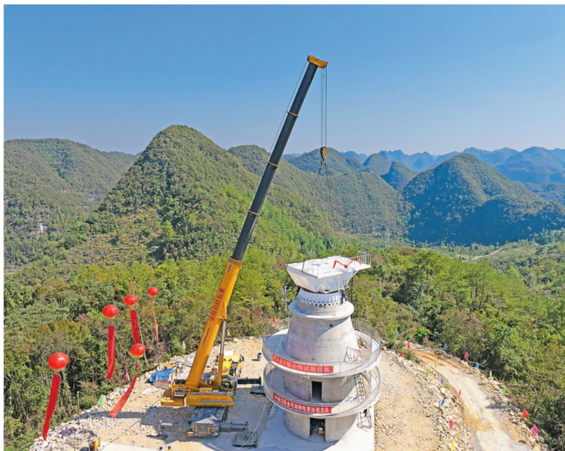
首台核心阵试验样机在吊装中(无人机照片)。
